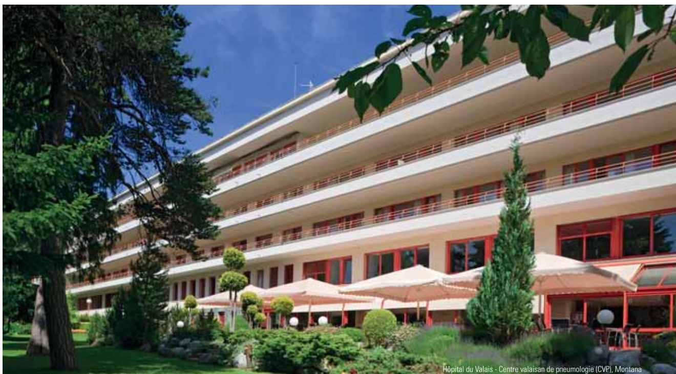
Hôpital du Valais - Centre valaisan de pneumologie (CVP), Montana
