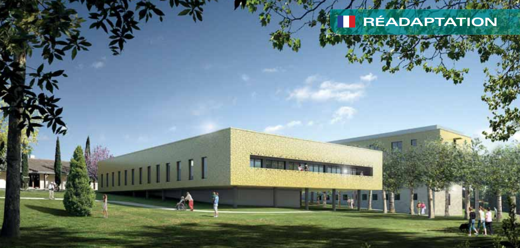
Centre de Soins de Suites et de Réadaptation de Château Lemoine à Cenon (33)
