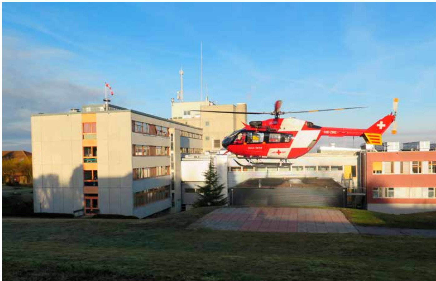
Hôpital Intercantonal de la Broye - Site de Payerne
